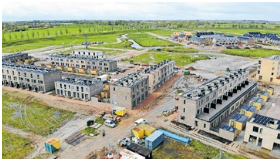
De Tippe is volop in aanbouw. Foto: Openbaar Belang.
